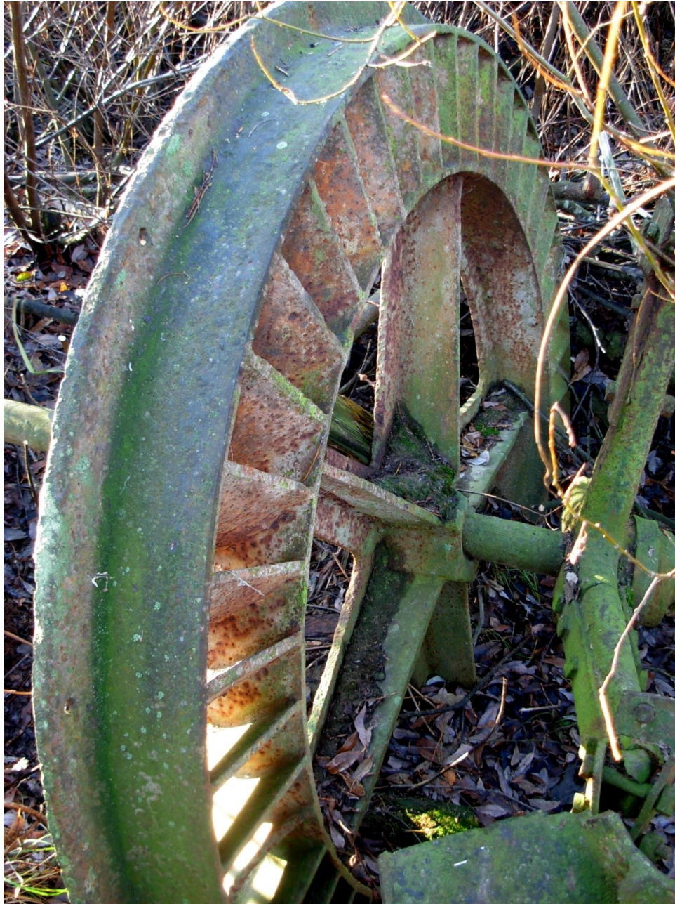
Ledskovelhjulet, sett underifrån, var nedfällt i en cirkelrund öppning i turbinsumpens botten (golv) så att kransen med bulthålen vilade mot underlaget och fastskruvad med bultar. Drivaxeln som löper igenom ledskovelhjulet och två av löphjulets ekrar syns också på bilden.
