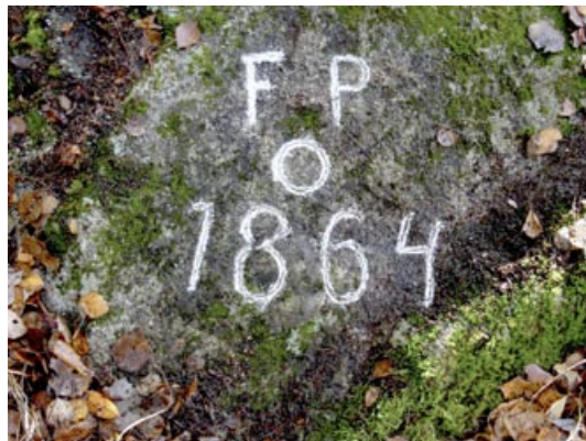
Fixpunkten inhuggen i en jordfast sten ovan dammen på östra stranden. Foto. Bertil Holmlund.
